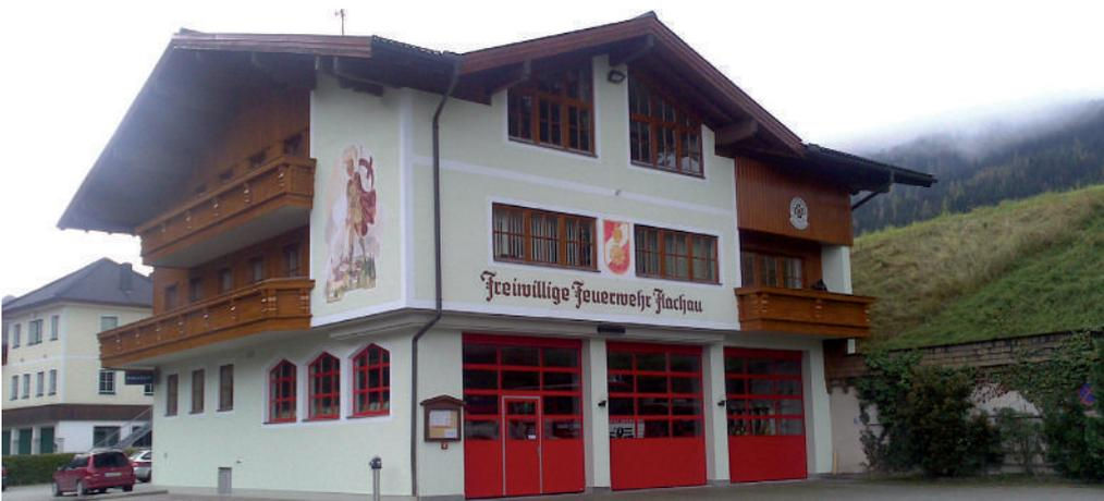
Beim Feuerwehrhaus Flachau wurden im abgelaufenen Jahr die desolaten Rolltore in die Fahrzeughalle ausgetauscht und die Fassade neu gefärbelt. Weiters wurden beim Balkon die schadhaften Teile ausgetauscht und der gesamte Balkon und die Holzschalung neu mit einer Wetter-schutzfarbe gestrichen.
